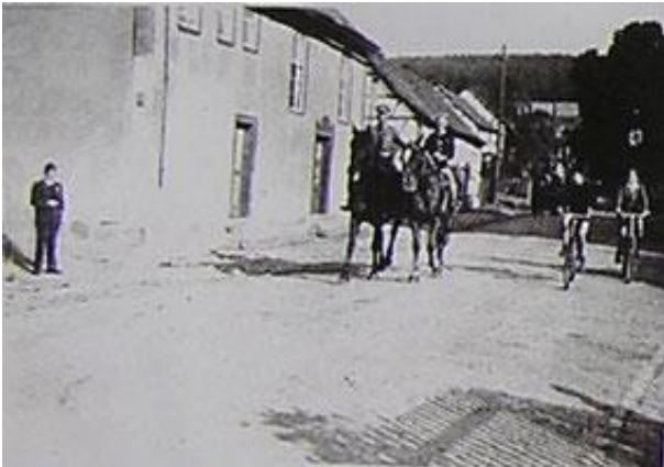
Die Synagoge in Wehrda
